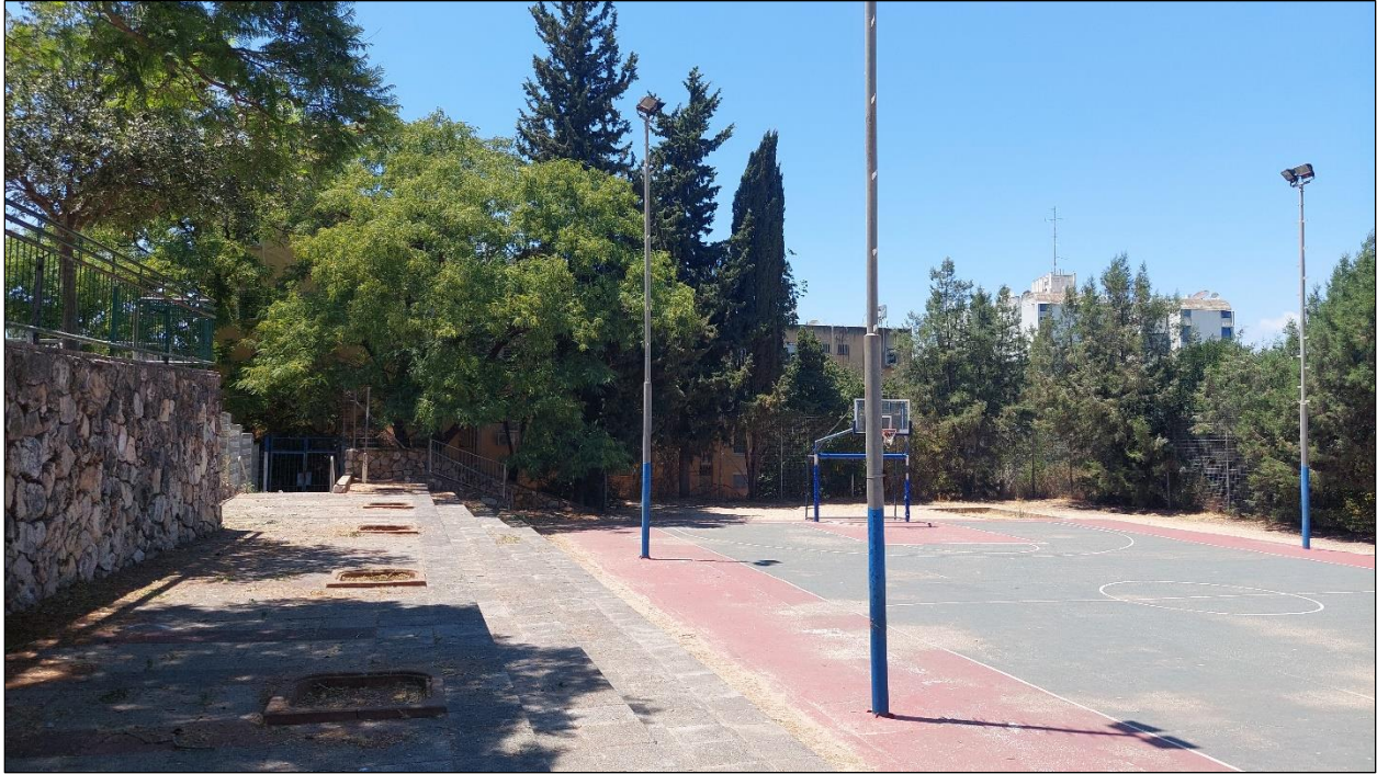
תמונה מס' 1 – מבט על האזור בו מתוכנן מבנה בית הספר החדש (מבט לכיוון צפ'-מע')
